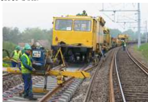
Longs Rails soudés sur traverses béton
